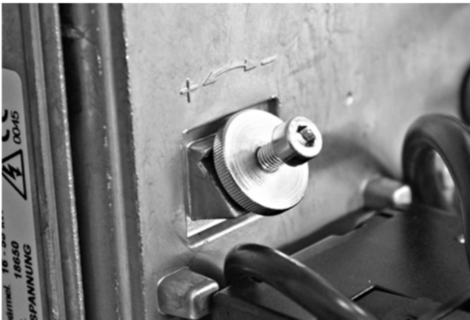
Abb. 11: Verstellerschraube der Luftklappe
