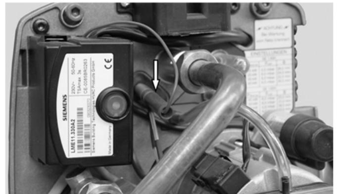
Abb. 19: Steckverbindung Ionisationselektrode
