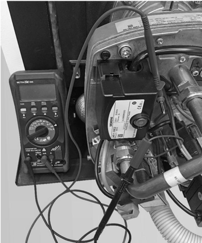
Abb. 21: Angeschlossener Multimeter
